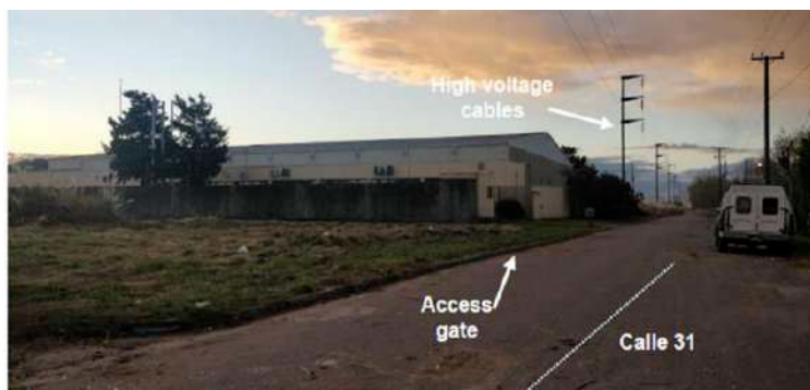
Figura 18: Vista de la estación Lumen
