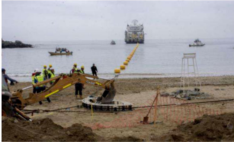
Figura 33: Tareas de instalación en aguas someras
