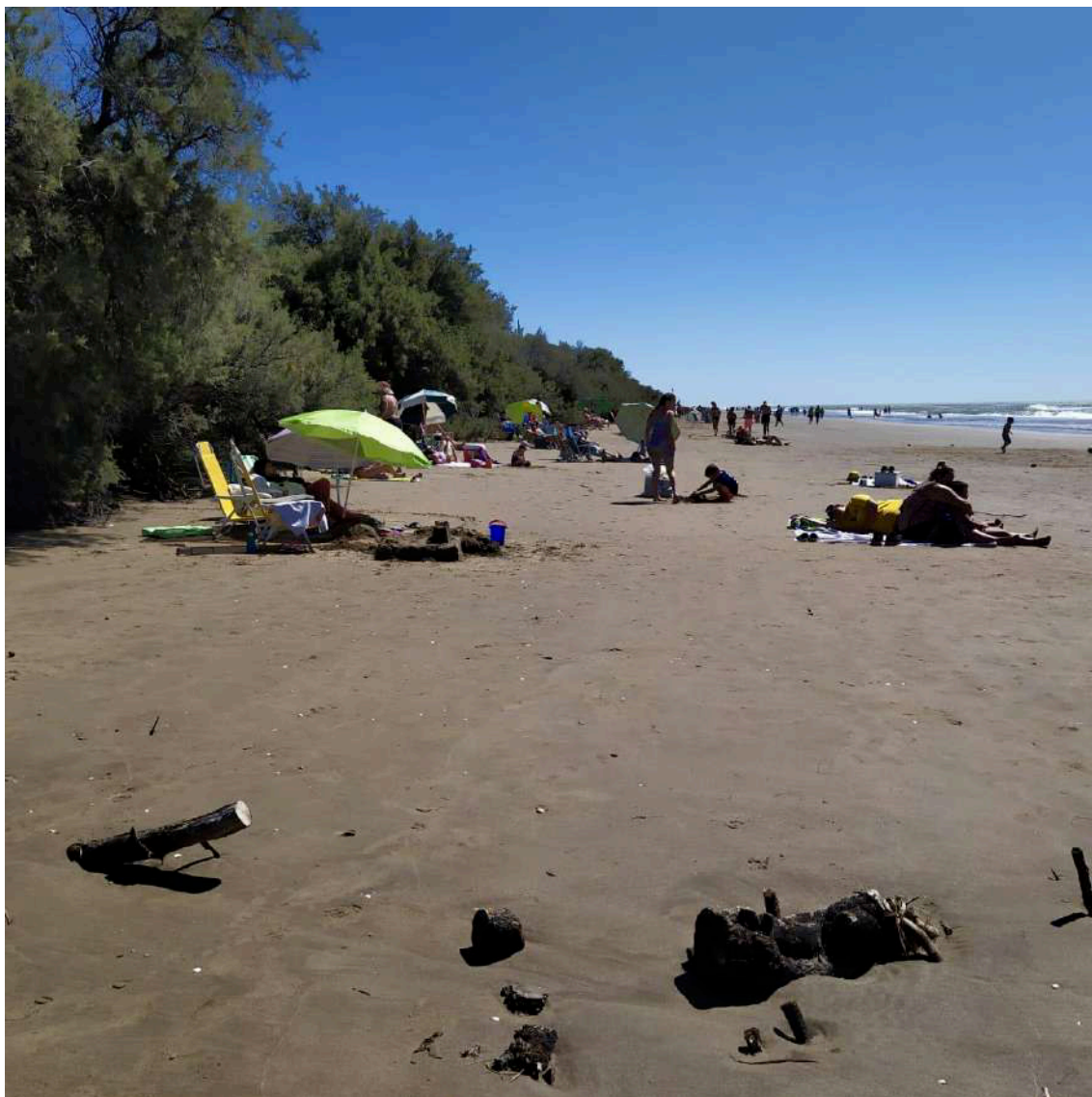
Figura 88: Imagen desde la calle 24 hacia el norte. Se puede distinguir la duna costera vegetada con tamariscos, sin desarrollo de playa distal. Véase al frente los restos de tamariscos, indican el activo retroceso de la línea de costa. La pleamar en sicigias alcanza la base de la duna costera
