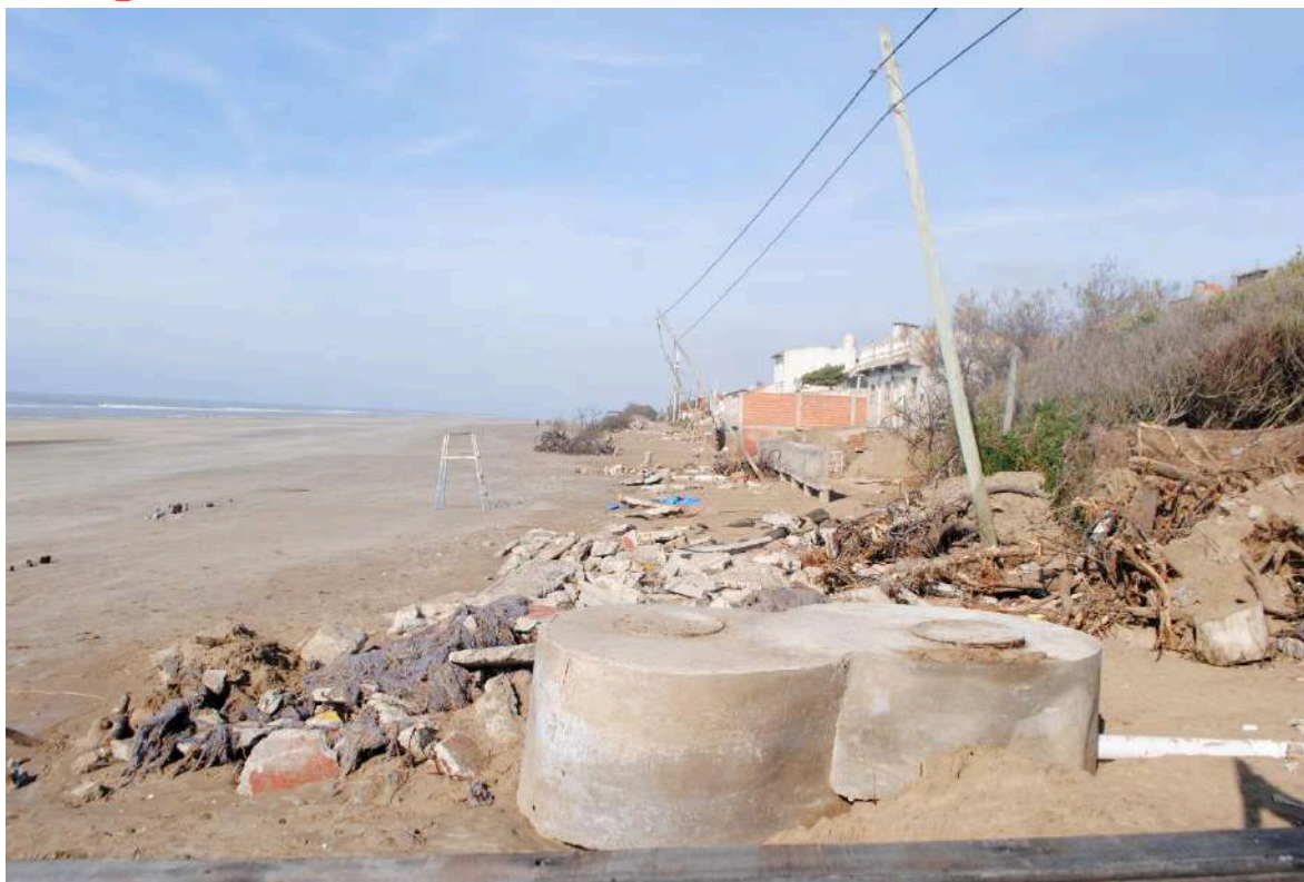
Figura 75: Pozos de registro cloacal expuestos luego de una sudestada ocurrida en invierno de 2021 y vuelco de postes de luz. Se registró un descenso del nivel de playa distal de más de 1 m al norte de Las Toninas.
