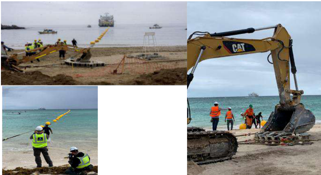
Figura 34: Esquema del proceso de aterrizaje del cable a la playa (Fuente: SubCom).
