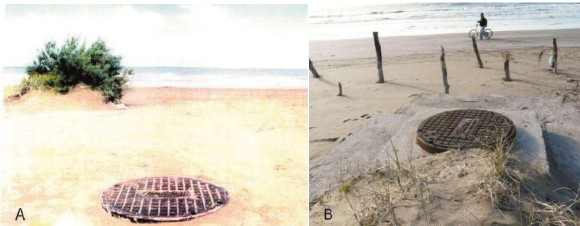
Figura 72: : A) posición de la tanquilla del cable SAM-1, en el año 2000. B). posición de la tanquilla en el año 2010. Se compara con la misma visual, de oeste a este.
