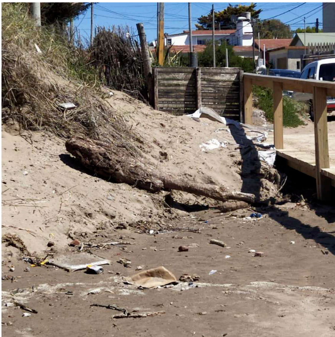
Figura 92: Erosión al sur de la pasarela de la calle 24. Nótese la caída de quinchos y las tareas de remediación con bolsas geotextiles rellenas de arena
