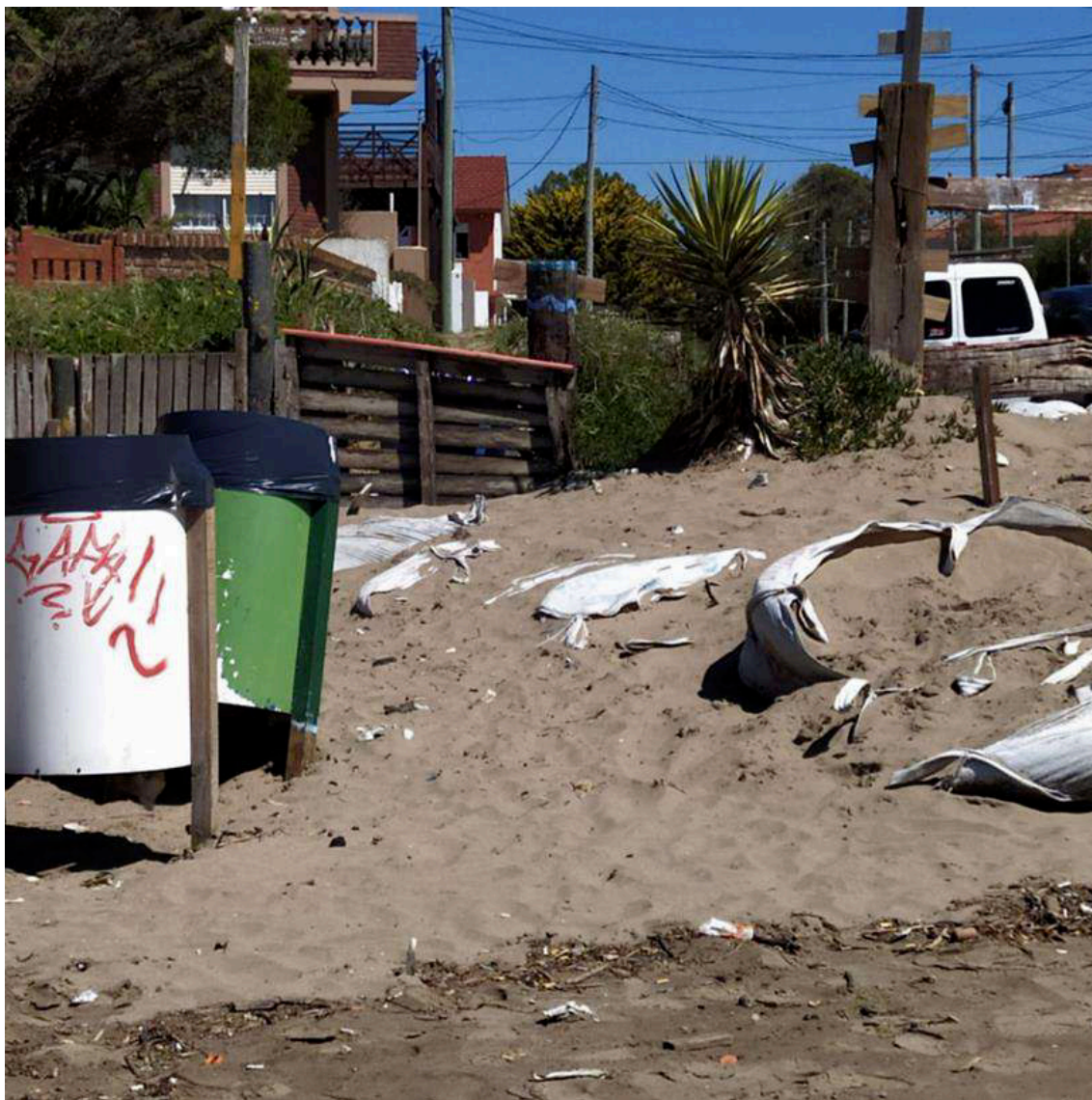
Figura 91: Tareas de remediación con bolsas geotextiles al norte de la pasarela de la calle 24 y presencia de especies alóctonas (yuca y uña de gato).
