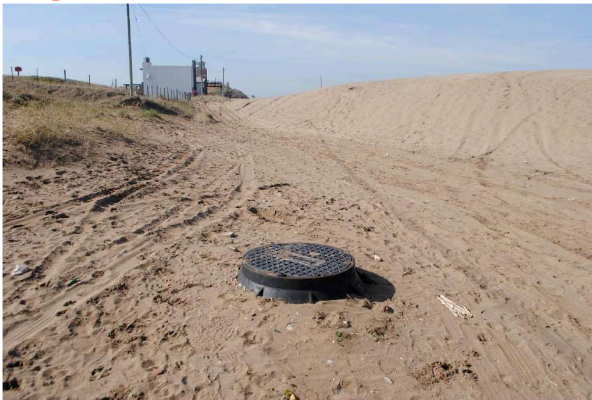
Figura 76: Exposición de estructuras por deflación eólica
