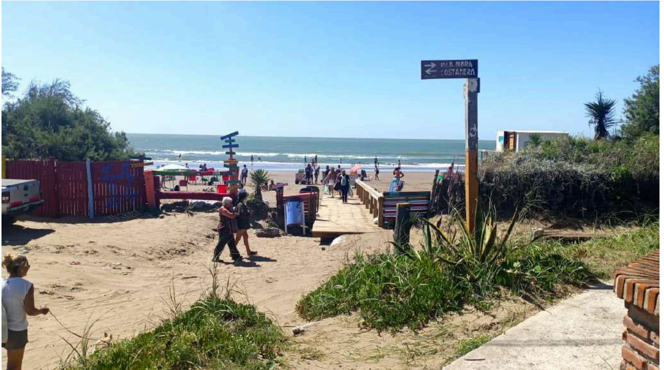
Figura 82: Vista del drenaje pluvial directo intermedio en la calle 24 por donde ingresará el cable.
